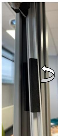
12) Remettre les parcloses en les plaquant contre les coulisses en les faisant coulisser, puis refixer les vis avec la clé BTR.
