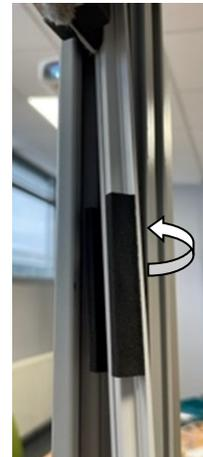
En haut du guide zip, la mousse néoprène est à environ 10 cm pour ne pas bloquer le passage du store et en bas du guide zip, la mousse néoprène est à ras.
