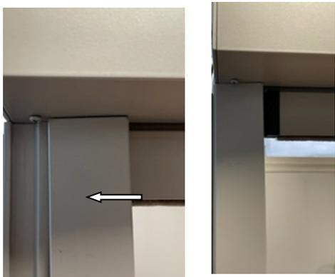
**!** Les mousses néoprène doivent impérativement être placées dans le retour de la coulisse pour ne pas gêner la toile.
