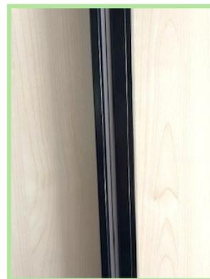
La mousse n'est pas visible et correctement placée dans le retour de la coulisse.
