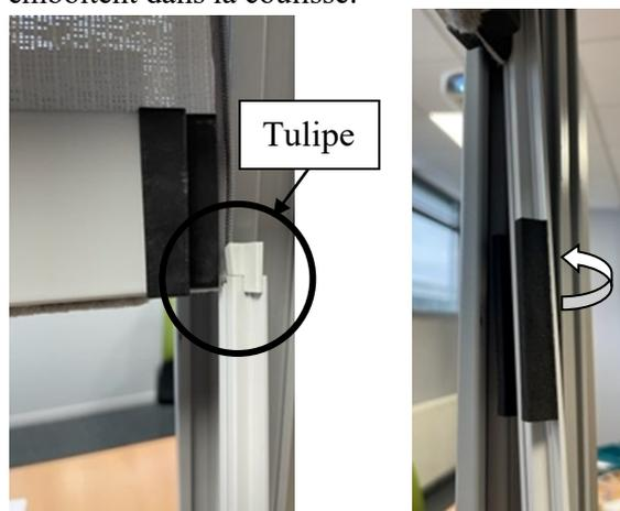
⚠ En haut du guide zip, la mousse néoprène est à environ 10 cm pour ne pas bloquer le passage du store et en bas du guide zip, la mousse néoprène est à ras.
