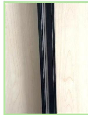
La mousse n'est pas visible et correctement placée dans le retour de la coulisse.
