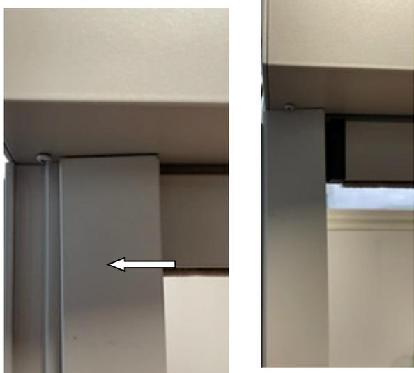
Les mousses néoprène doivent impérativement être placées dans le retour de la coulisse pour ne pas gêner la toile.
