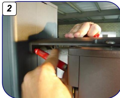
Tracer le positionnement de la platine anti-vibration puis enlever le moteur Totem
