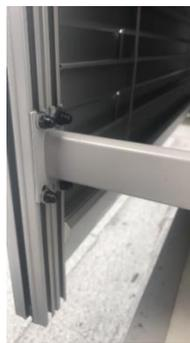
Nota : Vérification du niveau du Visio BSO et modifier la position des coulisses si besoin.
