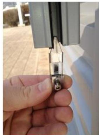
3) Remonter le tablier pour mettre en place les embouts de coulisse verrou (BSO-EMBCOUV).
