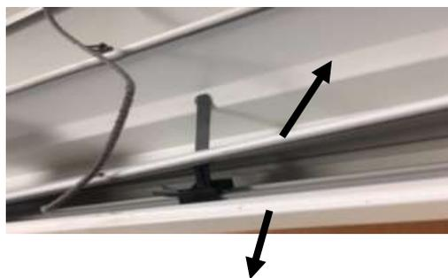
6. Prendre la nouvelle lame finale et remettre les clips ruban en les coulissants.
