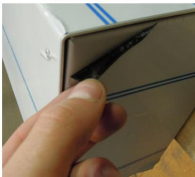
**!** Une fois le lambrequin entièrement fixé, le BSO installé et les protections retirées il est conseillé de faire un joint silicone le long de la languette supérieure de lambrequin ainsi que sur les deux retours latéraux pour assurer une parfaite étanchéité du système.
