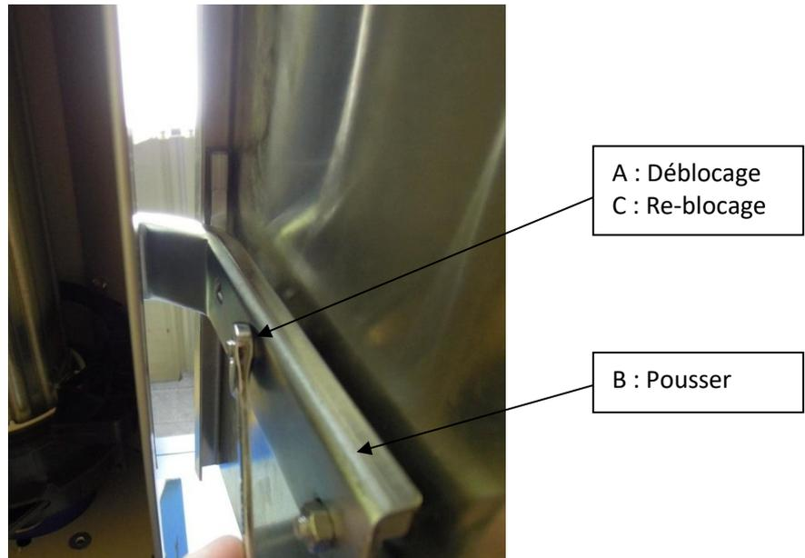
14- Positionner vos pousseurs inférieurs sur vos équerres. Caler les pousseurs inférieurs dans le retour du lambrequin. Fixer avec les boulons.
