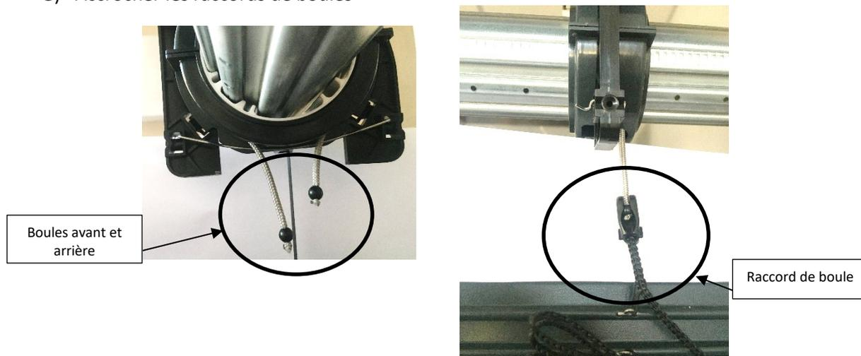
Insérer la boule avant dans le raccord de boule côté extérieur du tablier.
