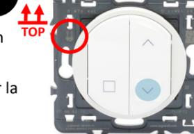
Appuyer sur le bouton DESCENTE, une seule fois pour vérifier le sens de rotation. Attendre 5 s, si le BSO ne bouge pas, appuyer une seconde fois sur le bouton DESCENTE
